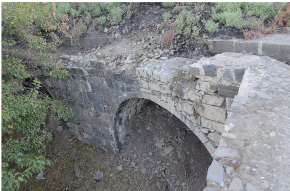
Ville de Diyarbakır
