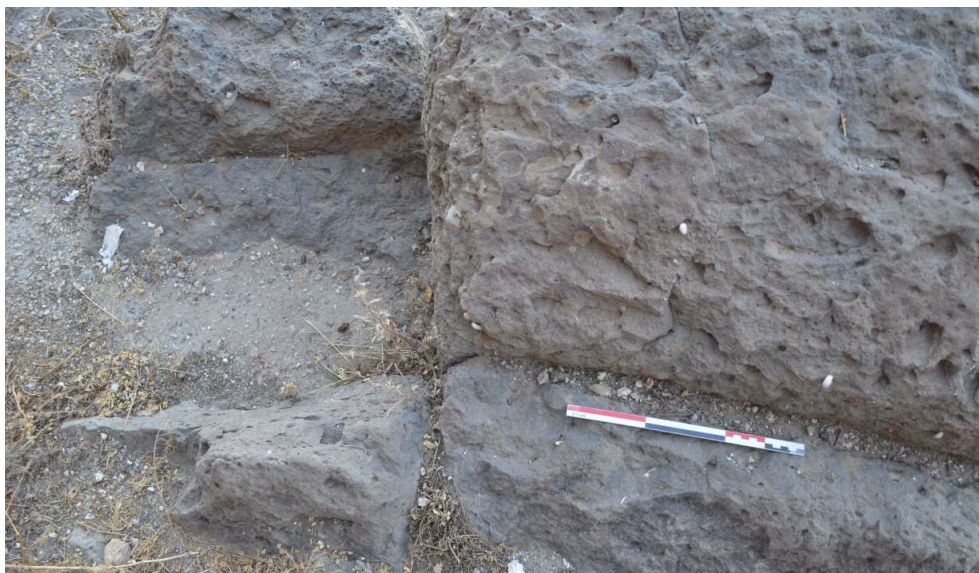
Figure 11 - Encoignure à la base d'un front de taille
