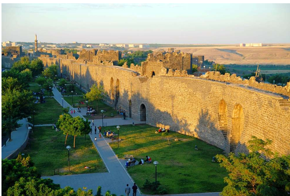
Figure 2 Vue du rempart, parement interne
