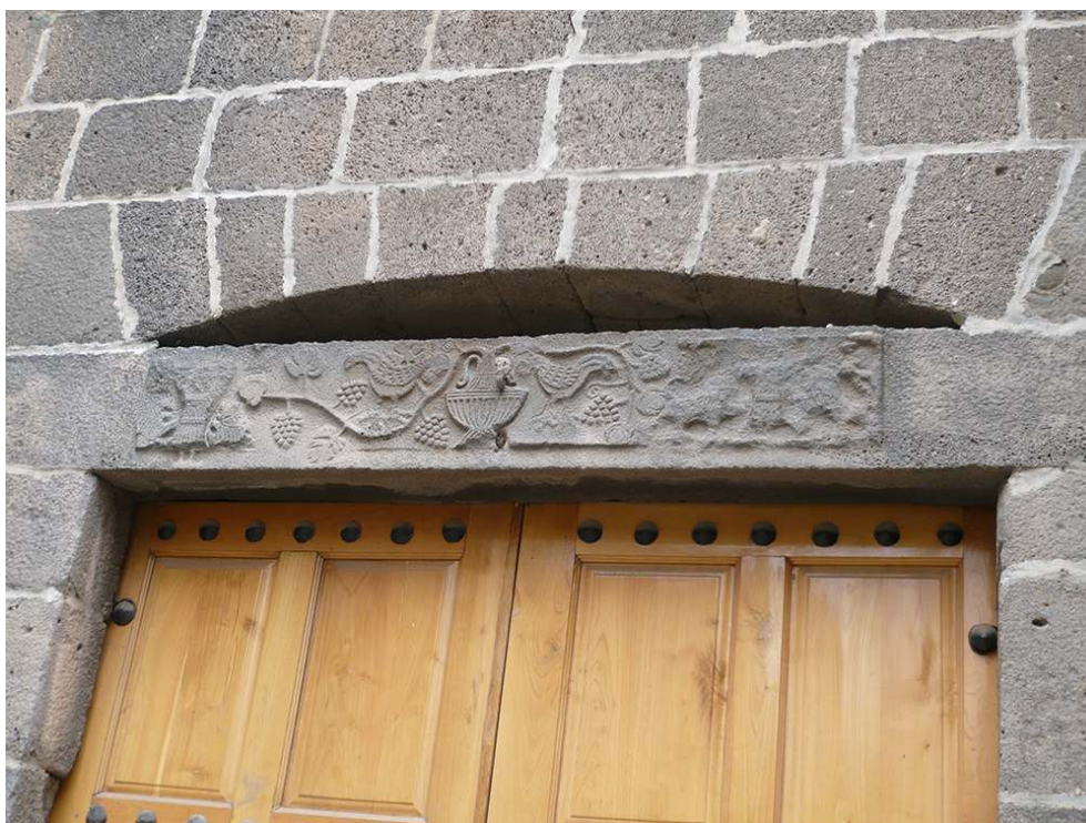
Figure 21 Linteau de l'entrée ouest de la ulu cami
