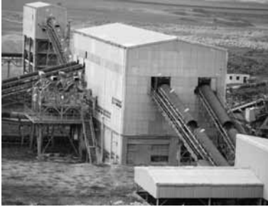
Şekil 3. Mazıdağı Fosfat Zenginleştirme Tesisi
